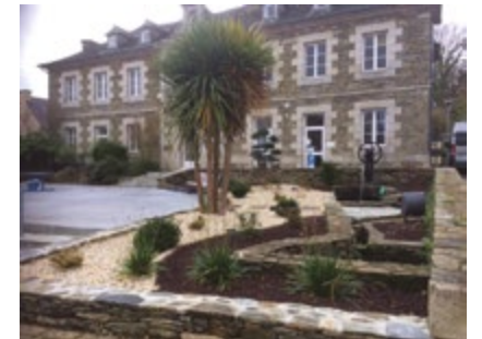
Le parvis rénové avec accès PMR de Ti an Holl
