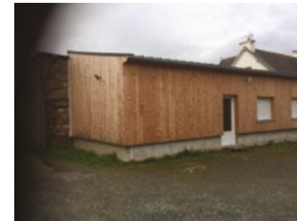
Le bâtiment rénové rue de Poul Scornet
