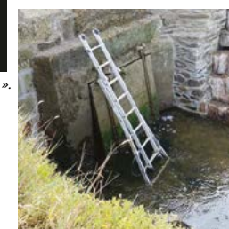
Travaux sur les vannes à marée de Rochelan
