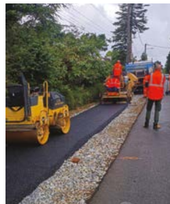
Cheminement piéton entre le bourg et la zone du Châtel
