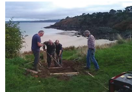
Réalisation de marches au-dessus de la plage de Tossen ar C'hoz
