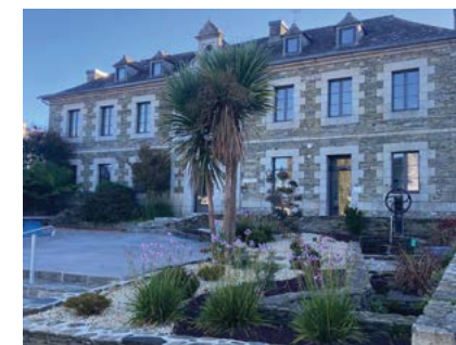
Rénovation thermique à Ti an Holl
