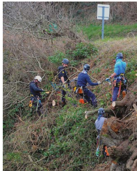
Sécurisation de l'accès au port de Beg Douar
