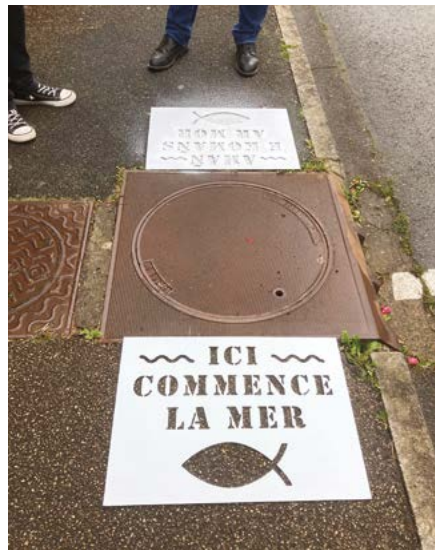
Marquage du réseau pluvial au pochoir
