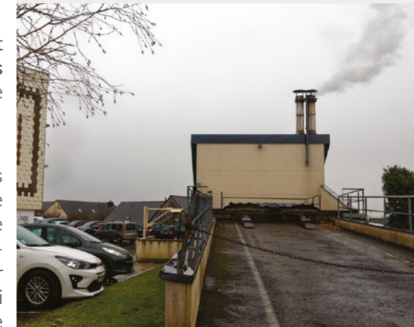
La chaudière bois
