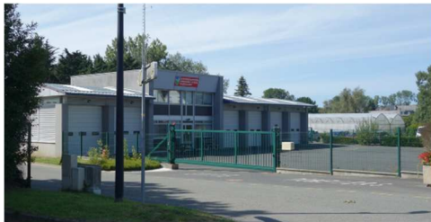
Centre d'incendie et de secours
