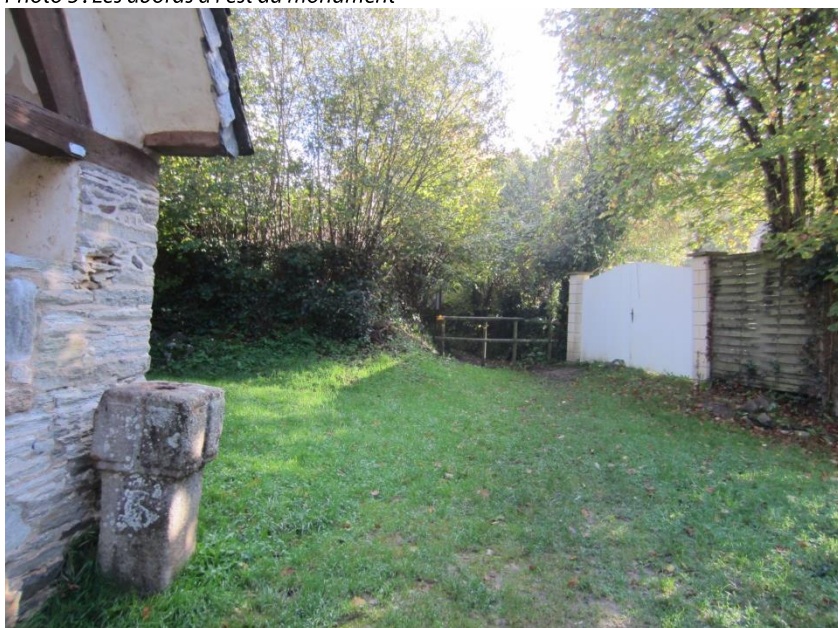
Photos 4 et 5 : Les abords à l'ouest du monument
