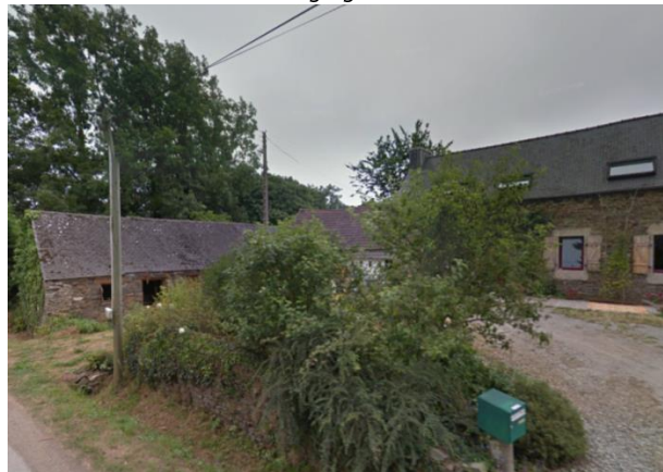
Photo 4 : Construction à Rugregon
