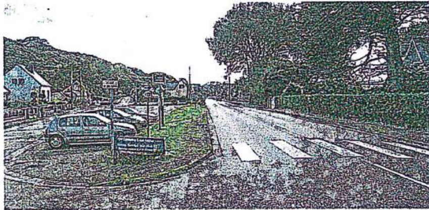
La loi littoral fait de Saint-Efflam un espace protégé, toute nouvelle construction, transformation extérieure ou nouveau changement d'affectation sont interdits dans la bande des 100 m à partir du rivage.
