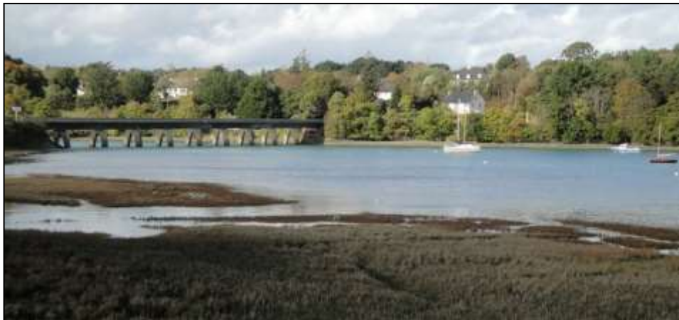
Pont de Toul-An-Héry : Jusqu'en 1934, pour rejoindre Plestin et Locquirec, il faut emprunter une barque menée par un passeur. Le pont est aménagé en 1934.
