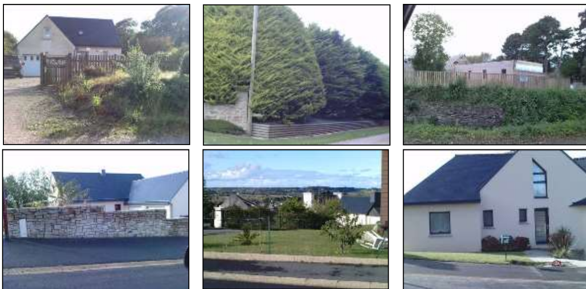
Traitement des limites
