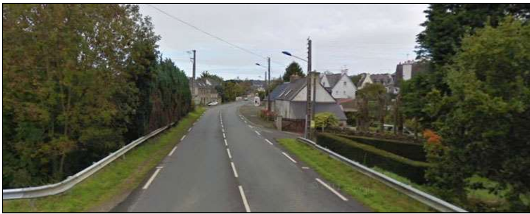
La RD 786, en périphérie sud du centre-bourg
