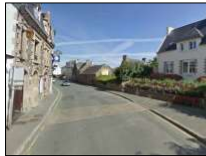
Vue sur le front bâti
