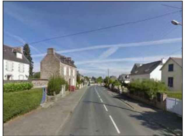
Vue sur le front bâti
