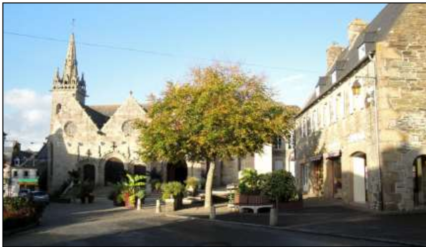
Le centre-bourg structuré autour de la place de l'église, cadrée de bâti traditionnel implanté à l'alignement
