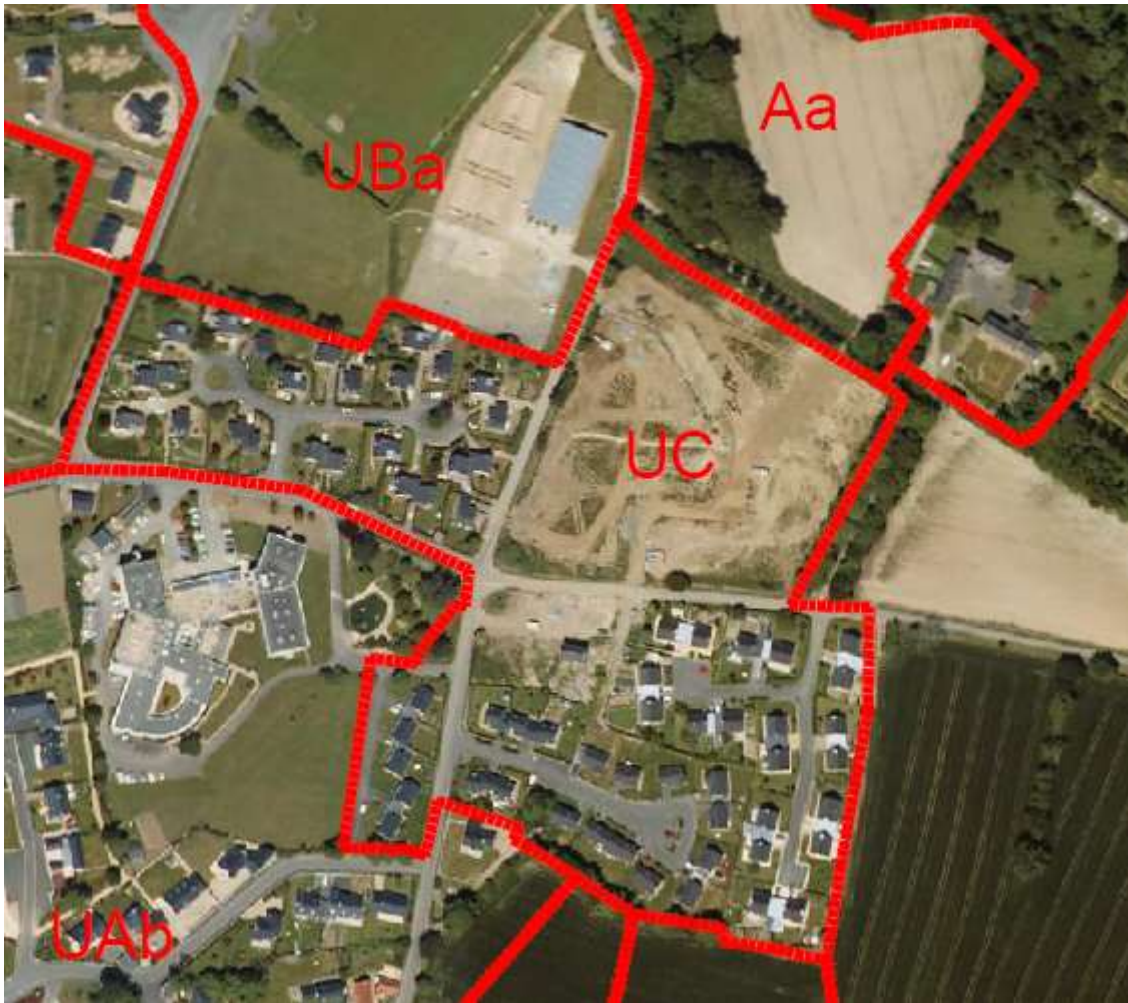
Secteur UC au nord-est de l'agglomération : des opérations groupées et des lotissements en cours d'achèvement
